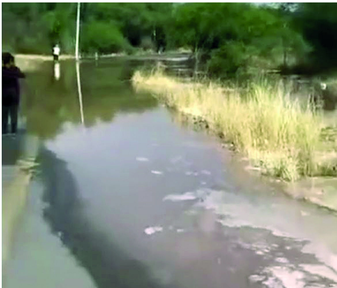
Habitantes de las colonias afectadas expresaron su molestia ante la recurrencia de las fallas en ducto de El Realito y la falta de un plan integral de solución definitiva
