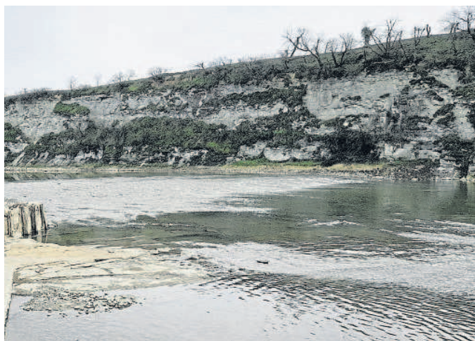
2025 ESTADO ACTUAL. Lo que era un muro de derivación de agua de dos metros de altura y 110 m de largo ha dado paso a una lámina de agua que fluye sin interrupción
