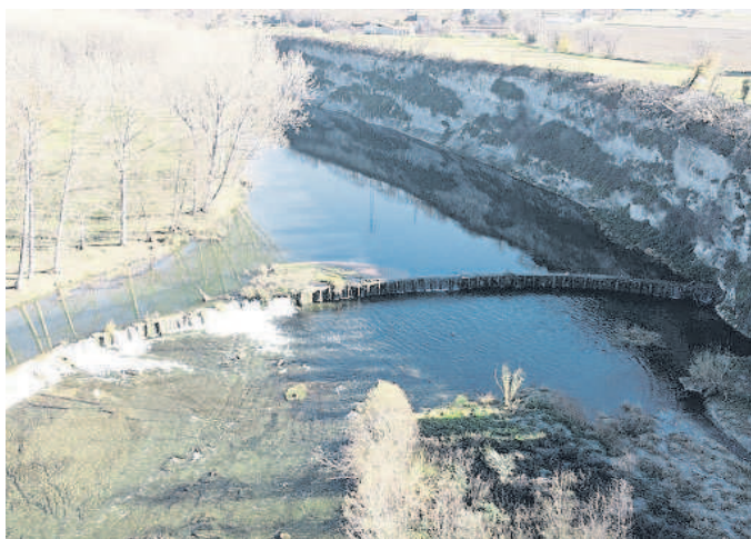
2024 ESTADO INICIAL. La actuación en Can Buxó (Manlleu), en el Ter, es un ejemplo representativo de la eliminación de una esclusa que bloqueaba la circulación del río
