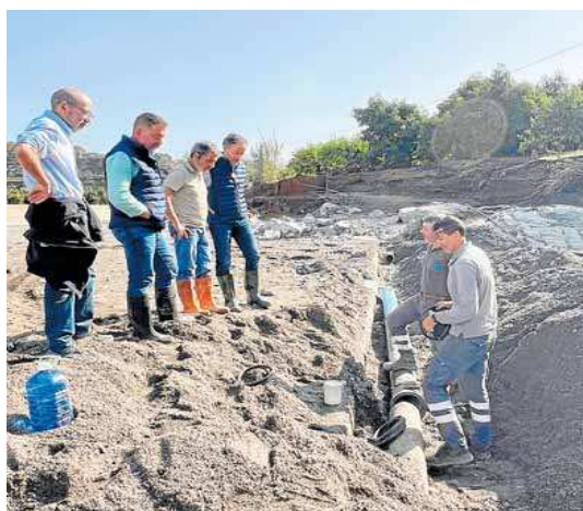
Trabajos de reparación de la tubería por los daños de la última dana. E. C.
